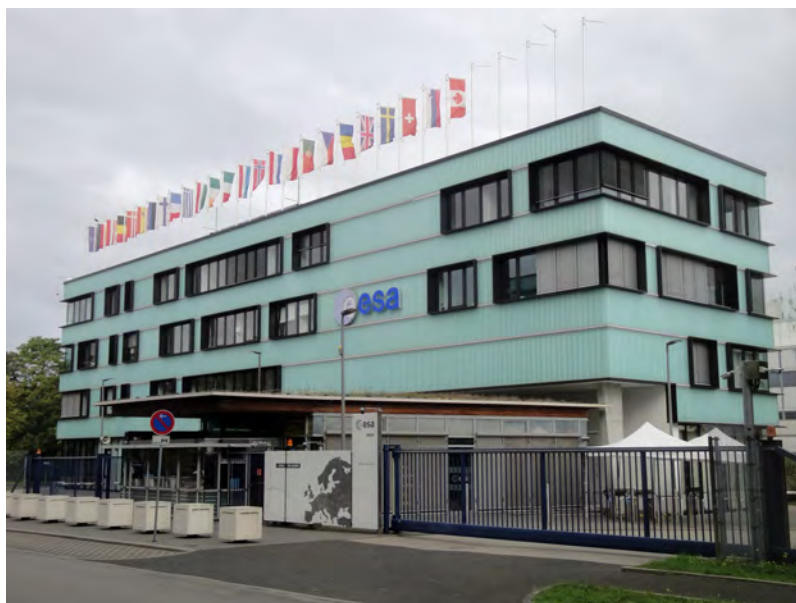
Europäisches Raumflugkontrollzentrum (ESOC) in Darmstadt
